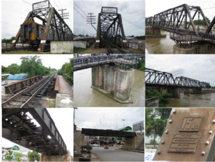
สะพานโครงเหล็กถักสามมิติ (Through truss) สะพานจุฬาลงกรณ์ (สะพานราชบุรี) ข้ามแม่น้ำแม่กลอง โดย ภาณุวัฒน์ จ้อยกสถิต
