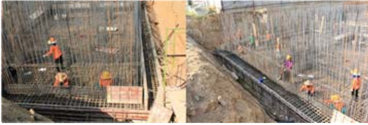
เป็น ถัง คสล. (Retaining
