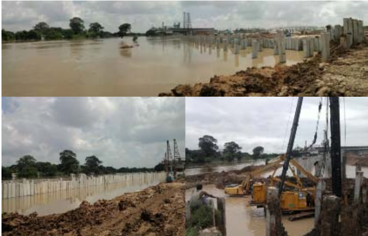
งานก่อสร้างเขื่อนป้องกันตลิ่ง
