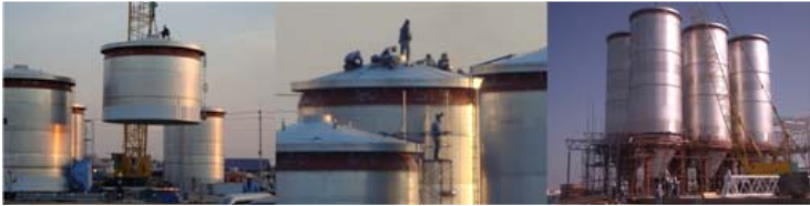
รูปงาน Erection ถัง (Silo)
