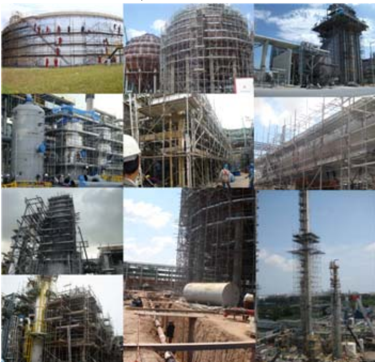
งาน Erection ตรงงานเปโตร
