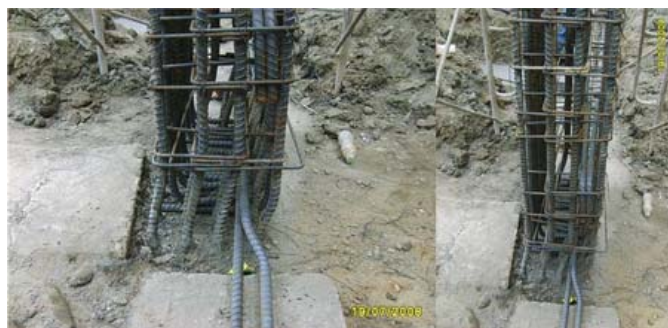
เสาเอียงศูนย์ ของจริยะ พรรณเชษฐ์ ป่านนี้ไม่รู้เป็นอย่างไร
