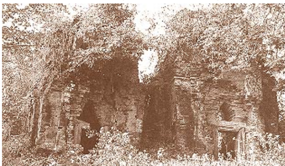
สภาพปราสาทหนองทองหลางก่อนบูรณะ
