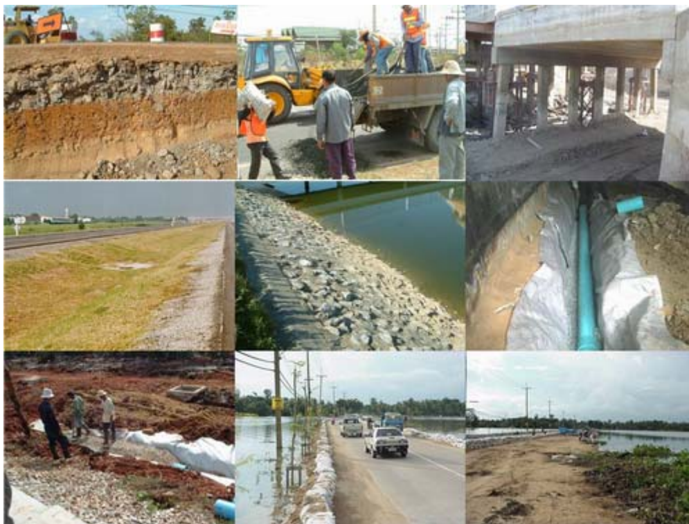
รูปที่ 9 ตัวอย่างวัสดุโครงสร้างทาง ปรับปรุงทางน้ำ ป้องกันลาด ระบายน้ำได้ดิน ร่อง หรือคันค้ำกษะ หรือตะกอน
