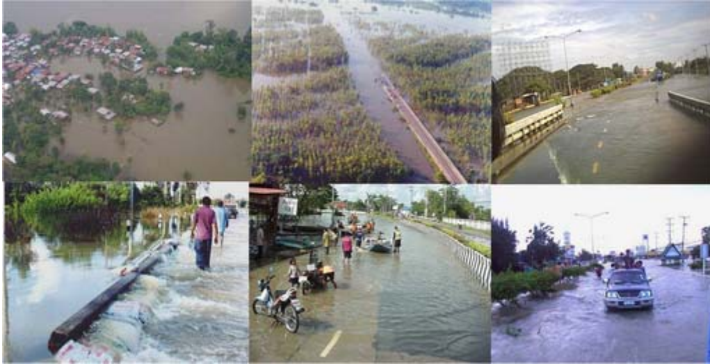
รูปที่ 2 สภาพน้ำท่วมในจังหวัดอุบลราชธานี ในพ.ศ.2545 ถนน สะพานชำรุดเสียหาย และอุปสรรคในการคมนาคมสัญจร
