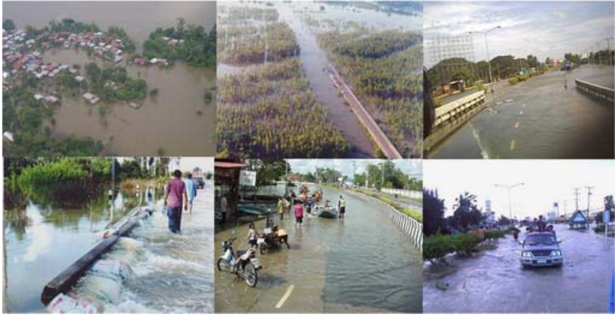
รูปที่ 2 สภาพน้ำท่วมในจังหวัดอุบลราชธานี ในพ.ศ.2545 ถนน สะพานชำรุดเสียหาย และอุปสรรคในการคมนาคมสัญจร
