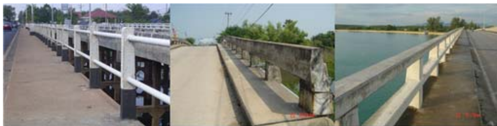
รูปที่ 8 ตัวอย่างราวสะพาน และระบบระบายน้ำที่เหมาะสมจะรองรับอุทกภัย
